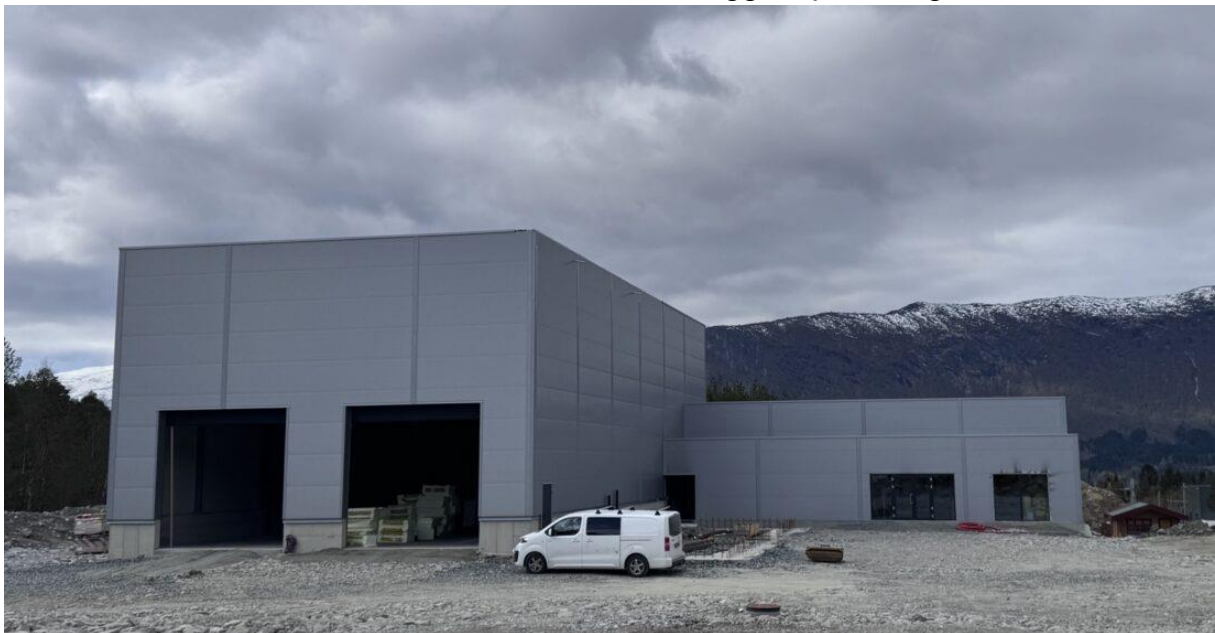
Fabrikkbygningen til Biolast er ferdig. Nå fylles den med innhold. (Foto: Biolast)
